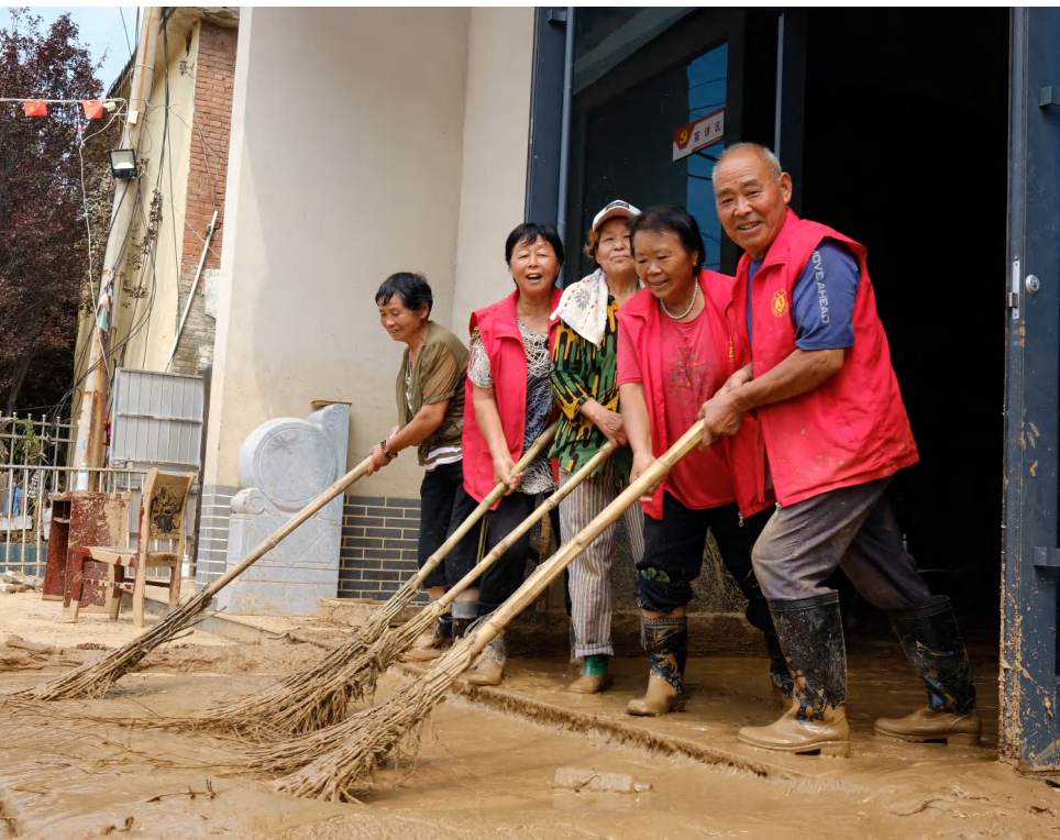
今年7月河南洪灾，中国扶贫基金会“重建家园——以工代赈项目”的受益村民进行屋内清淤。（图/中国扶贫基金会）
