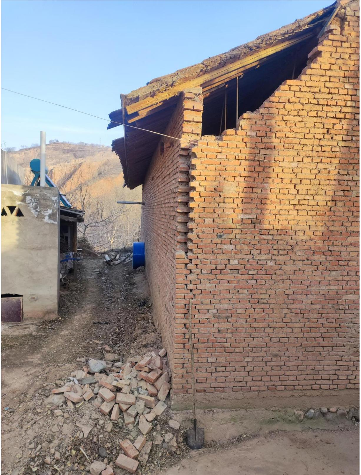
图 17 积石山县一户典型的砖木结构住房，没有墙角构造柱，墙体纵横连接处裂开。摄影：徐诗凌
